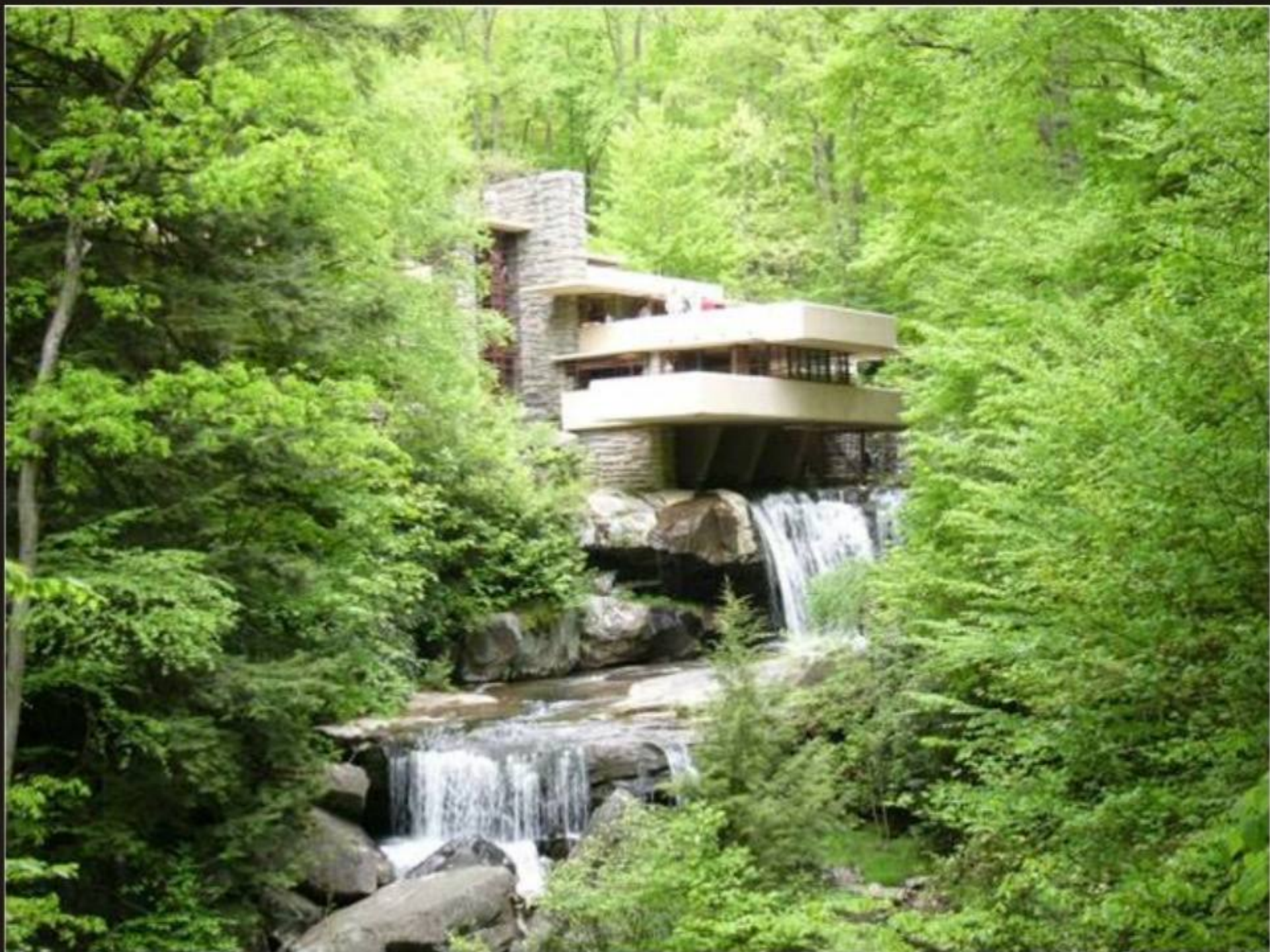
Gambar 7.46 Komposisi warna The Falling Water rancangan arsitek Frank Lloyd Wright yang menyatu dengan warna-warna alam pada lingkungannya. Daksina: Wikipedia
