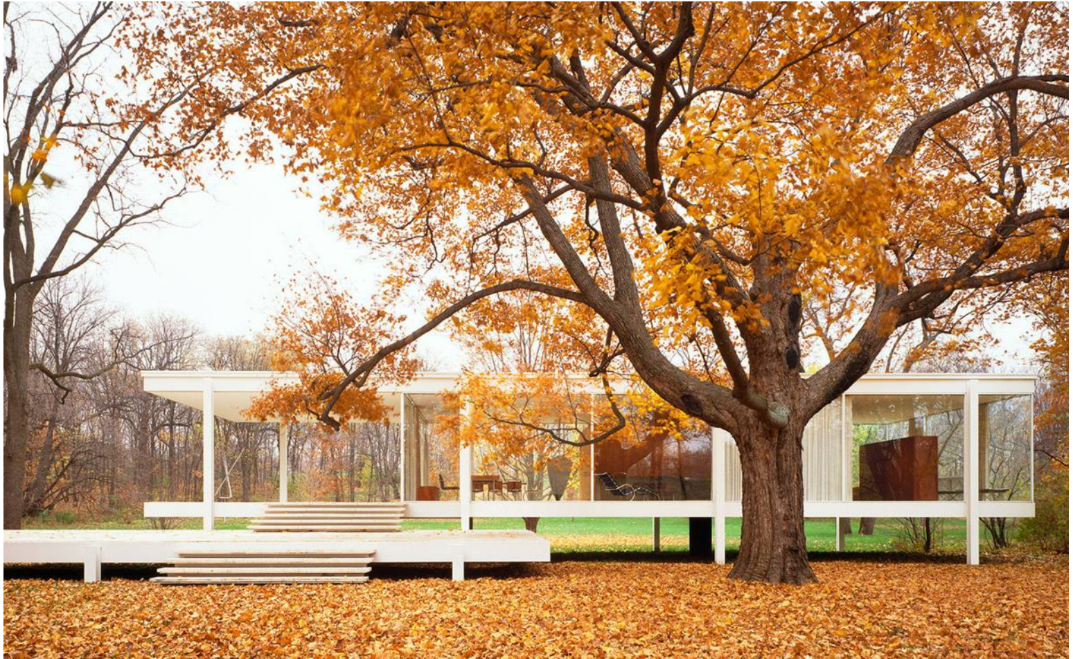
Gambar 7.47 Struktur rangka The Farnsworth House, Plano (1951), dijadikan daya tarik bangunan. Menggunakan warna putih yang kontras dengan lingkungan lansekap, struktur ini menonjol sebagai bentuk visual utama.
